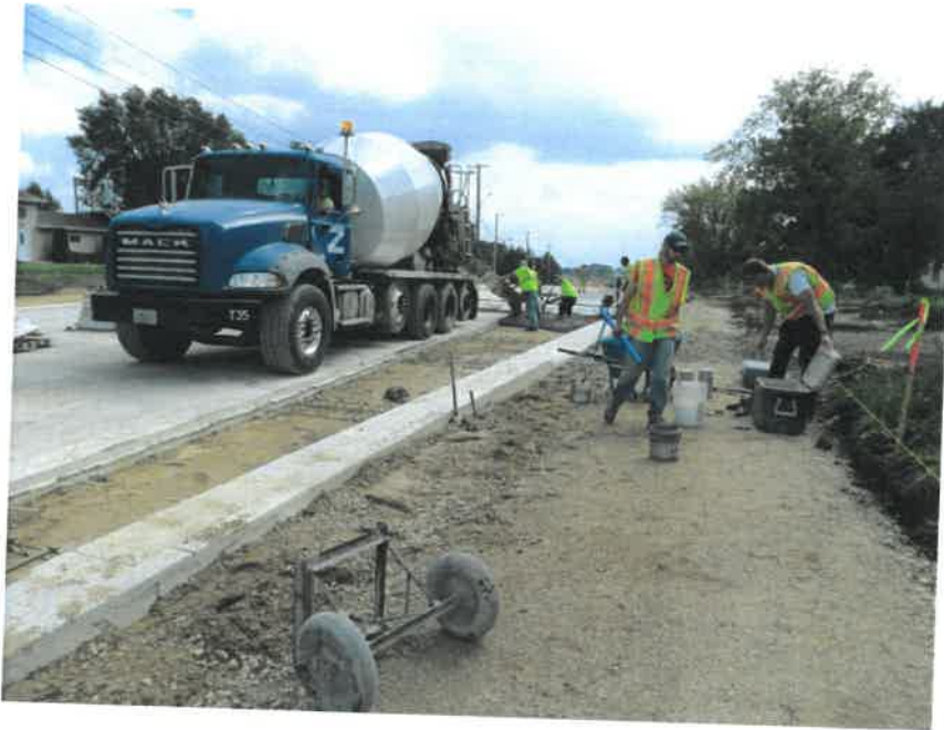
Concrete pavement hand pour
